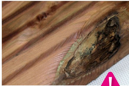
Výlomy hran – přípustné do 20 mm, maximálně dva na běžný metr
